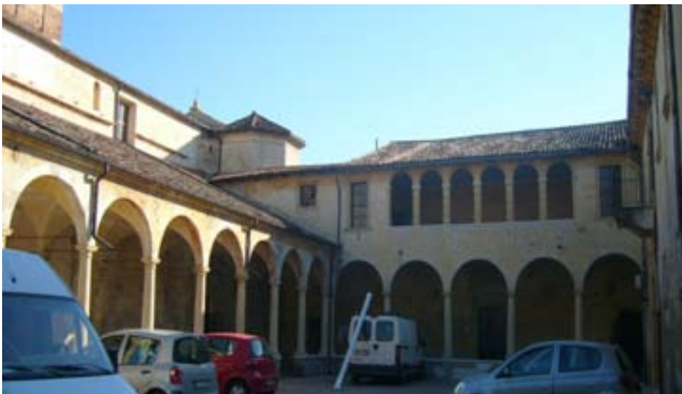
Vista del prospetto sud e chiostro
