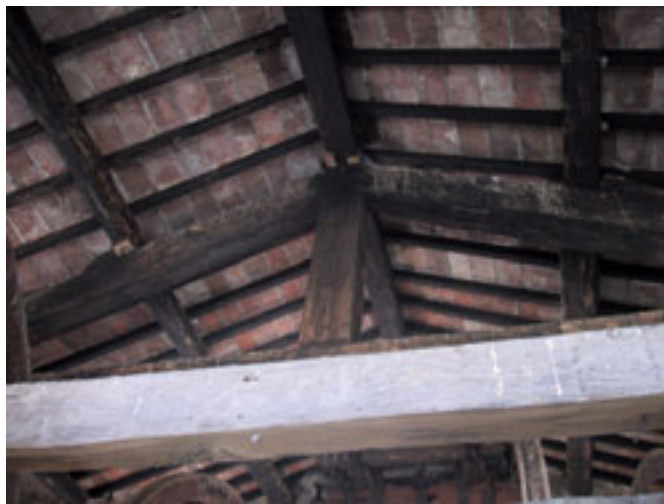
Particolare della capriata lignea di copertura
