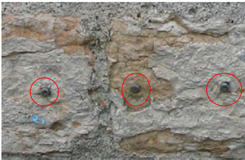
Foto 3. particolare delle piastrine metalliche incollate alla muratura
