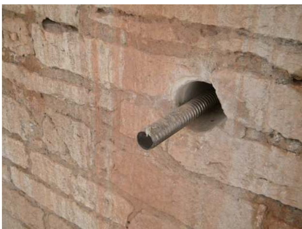
Inserimento dei tiranti a filettatura continua
