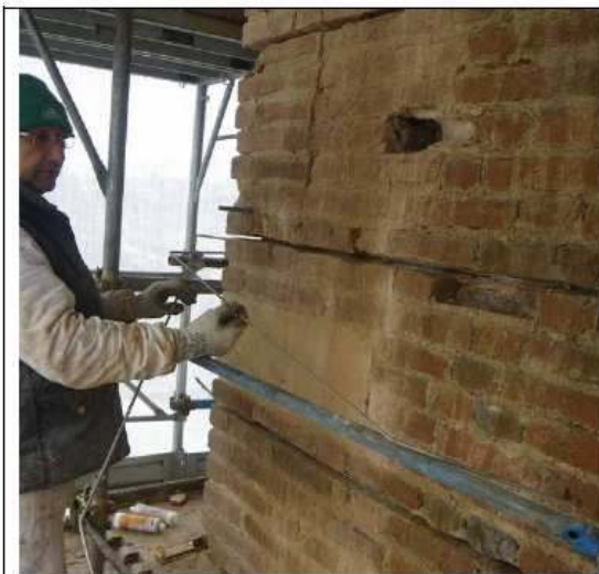
Fasi di inserimento delle legature
