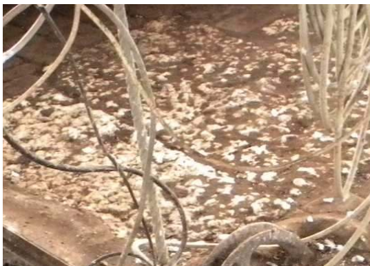
Natura del pavimento della cella campanaria dopo la rimozione del guano.
