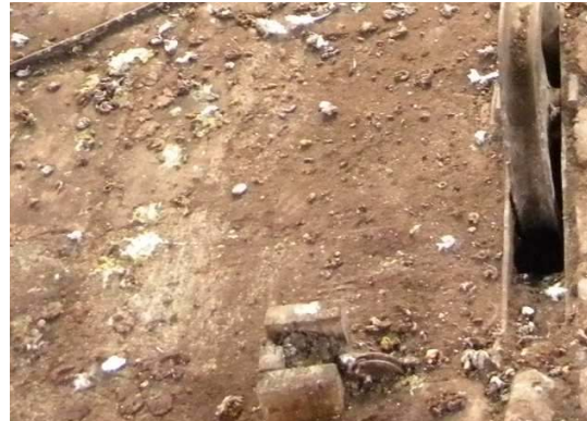
Natura del pavimento della cella campanaria dopo la rimozione del guano.
