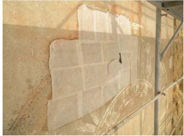
Preconsolidamento dell'intonaco dei quadranti con stuccatura salvabordo e velinatura
