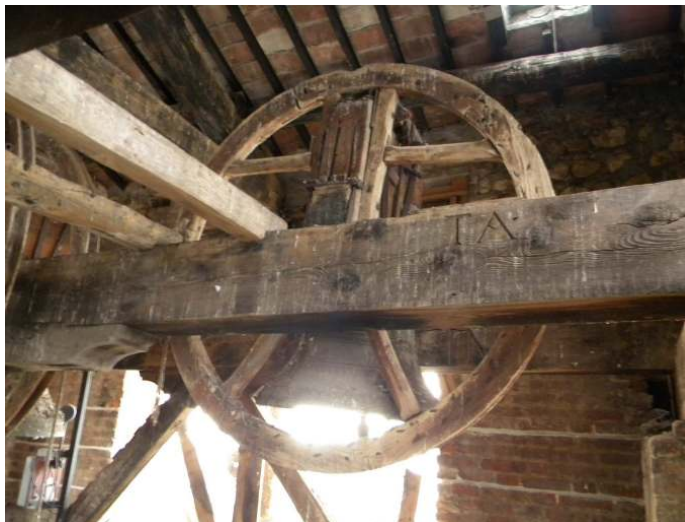
Dettagli di testata di una trave del castello campanario e ruota.
