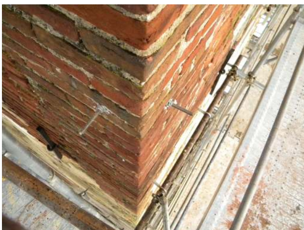
Esecuzione degli interventi b) e c)
