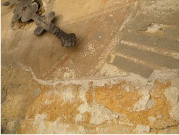
Preconsolidamento dell'intonaco dei quadranti con stuccatura salvabordo e velinatura
